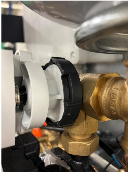
Figuur 22: 3-weg klep en servomotor met zwarte schijf.
