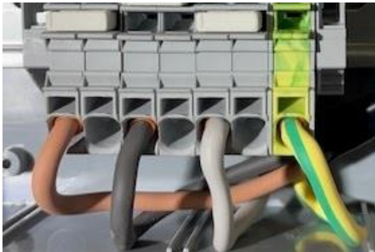
Figuur 32: Doorvoerklemmen met de juiste aansluiting van de 4-aderige kabel.
