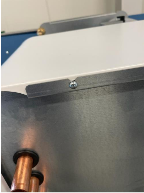
Figuur 28: Bevestiging van bout in onderkant van de onderkap.
