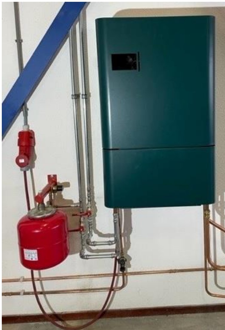
Figuur 1: Voorbeeld van een CVi systeem.
