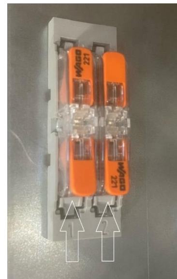
Figuur 36: Doorvoerklemmen voor de thermostaat aansluiting.
